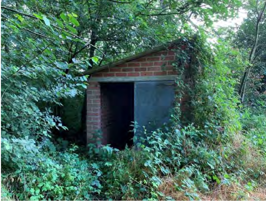
Afbeelding 4.59: het verlaten hok in 2x wordt afgebroken (Greenspot, 18 juni 2020).
